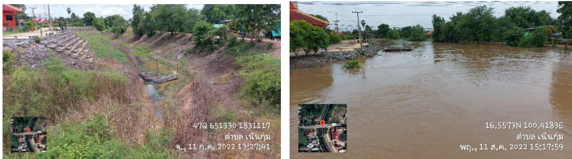
ภาพที่ ๒๖ โครงการเขื่อนระบายน้ำวัดตายม พิกัด UTM ๖๕๑๓๓๐ ๑๘๓๑๑๑๗
