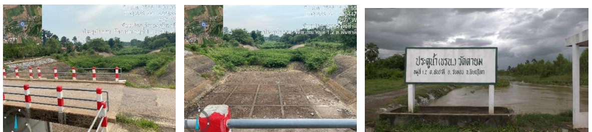
ภาพที่ ๑๘ โครงการเขื่อนระบายน้ำวัดตายม ตั้งอยู่หมู่ ๑,๒ ตำบลพันชาลี อำเภอวังทอง พิกัด UTM ๖๕๘๑๙๙ ๑๘๓๘๔๕๘ เส้นทางน้ำไหลจาก ตำบลพันชาลี อำเภอวังทอง ไหลมาสู่ ตำบลวัดตายม-ตำบลเนินกุ่ม ออกไปยัง อำเภอสากเหล็ก จังหวัดพิจิตร
