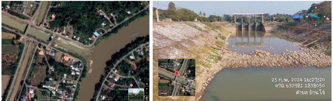
ภาพที่ ๑๖ โครงการส่งน้ำและบำรุงรักษาพลาญชุมพล ณ ประตุนะบายน้ำ DR.๒.๘ หมู่ ๘ ตำบลบ้านไร่ อำเภอบางกระทุ่ม เพื่อระบายน้ำจากแม่น้ำยมลงสู่แม่น้ำน่าน ที่ไหลผ่านอำเภอบางกระทุ่ม
